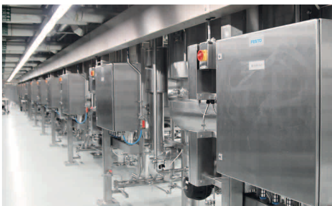
200 komplett anschlussfertige Edelstahl-Schaltschränke von Festo mit rund 5000 Ventilfunktionen für knapp 80 Ansatzbehälter und Bioreaktoren.
