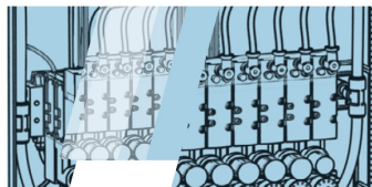
Sicherheit und Überwachung Sichtschilde bieten Schutz und ermöglichen Kontrollen ohne Öffnen des Schrankes
